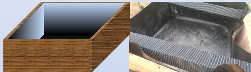
2. 護欄內鋪設不透水布
