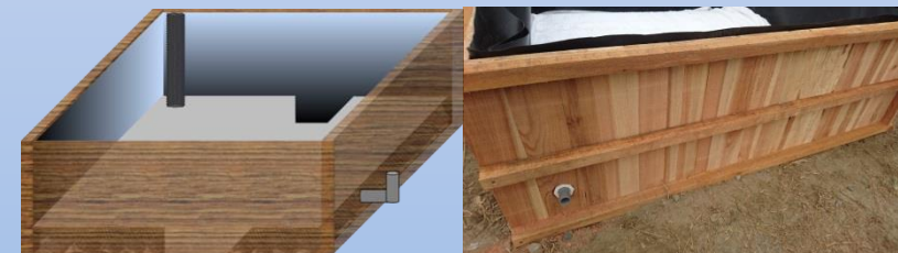
6. 安裝進水管及溢水管
