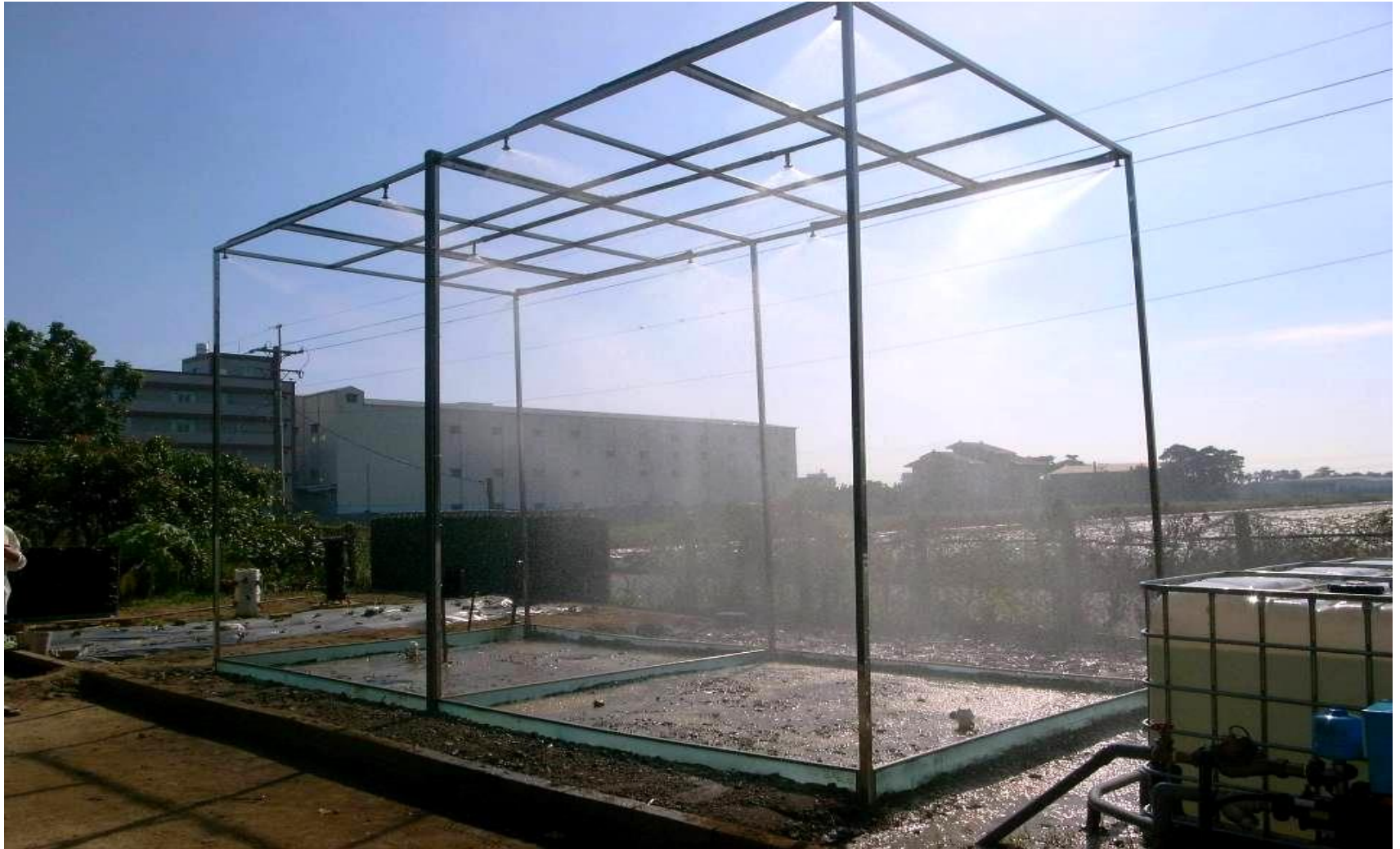
施工完成後，實際降雨實測時拍攝。
