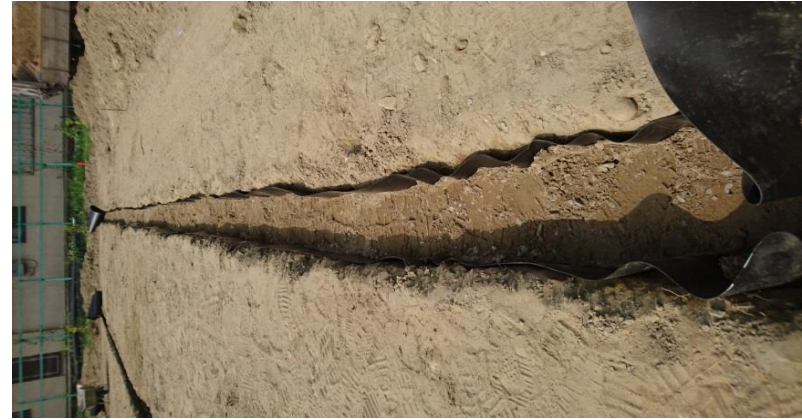
不透水布溝內鋪設3/8"碎石級配，整平、夯實。
