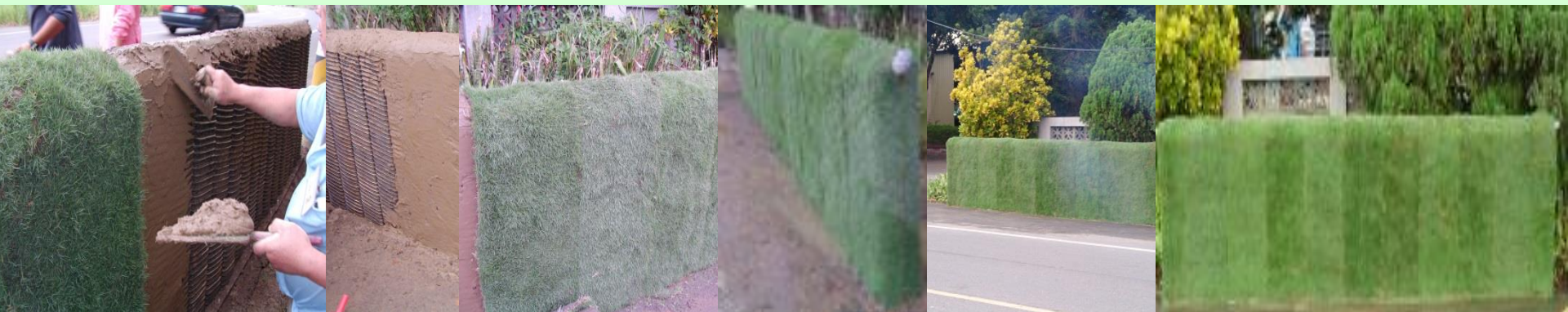
4. 將混合之介質加水混勻後覆蓋在網管表面
