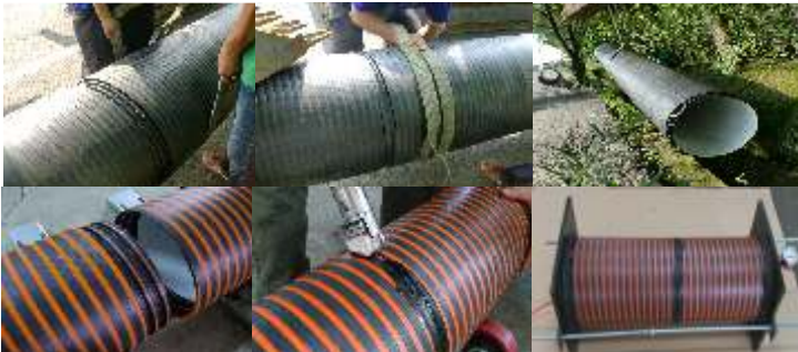
以噴燈徐徐加熱於火 烘布套筒表面火烘布 收縮貼於排水管表面
